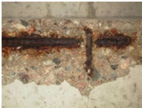
Exempel på skadad balkong. OBS! Annat objekt!
